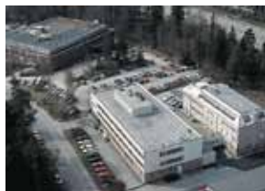
Centre mondial de thermographie de FLIR Systems à Stockholm
