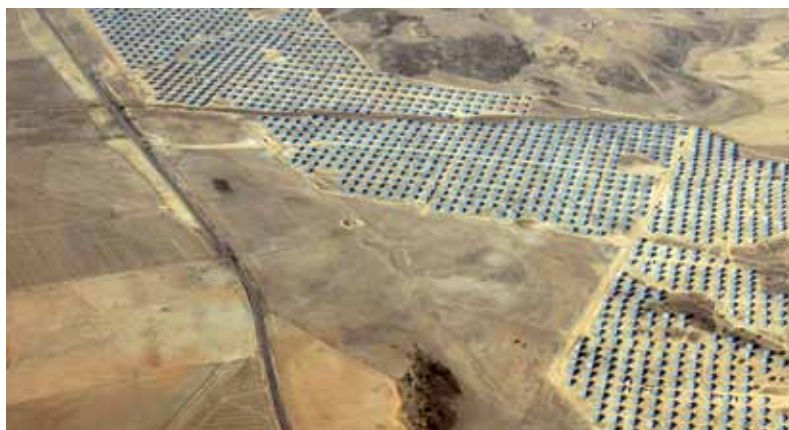
La centrale solaire photovoltaïque Abertura couvre une surface de plus de 200 hectares. Elle possède plus de 132.000 panneaux solaires sur 2.112 facettes, pour une puissance installée de 23,1 MW crête.
