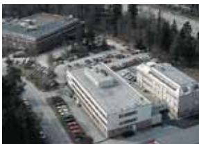
Centre mondial de thermographie de FLIR Systems à Stockholm
